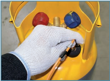
Зураг 7. OFP-ын холболтыг юүлэх бортогод холбох нь
