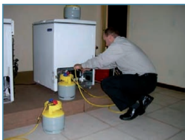
Зураг 23. Юүлэх бортогог байрлуулах.
