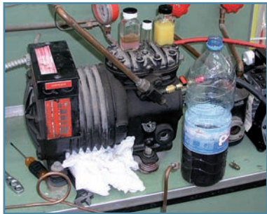
Зураг 18. Хагас задгай компрессороос тосны дээж авч байна.
